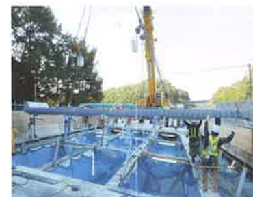
新しい床版の架設
