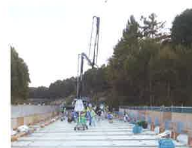
床版の間詰コンクリート打設
