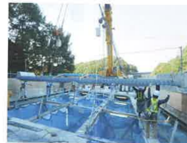
新しい床版の架設
