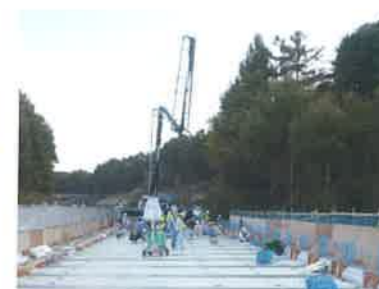
床版の間詰コンクリート打設
